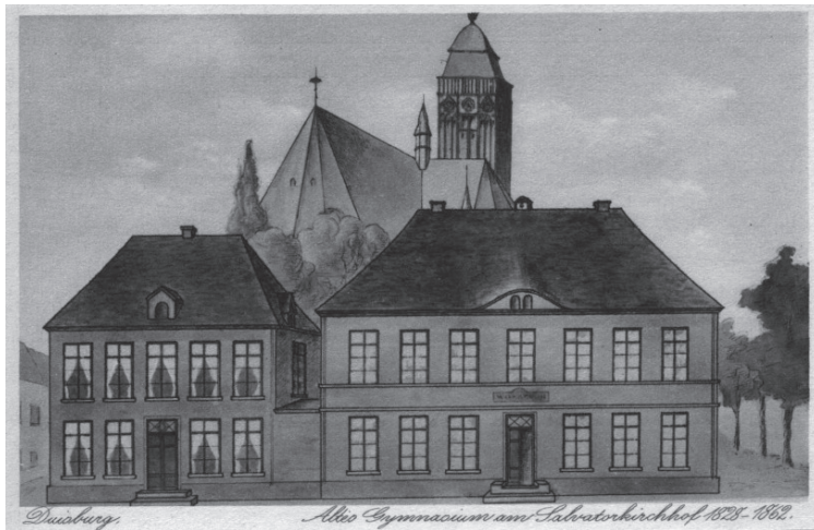
Das Gymnasium von 1828-1862
